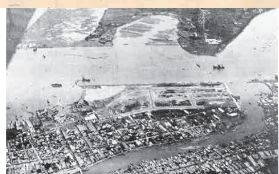
第二期修築工事の風景
